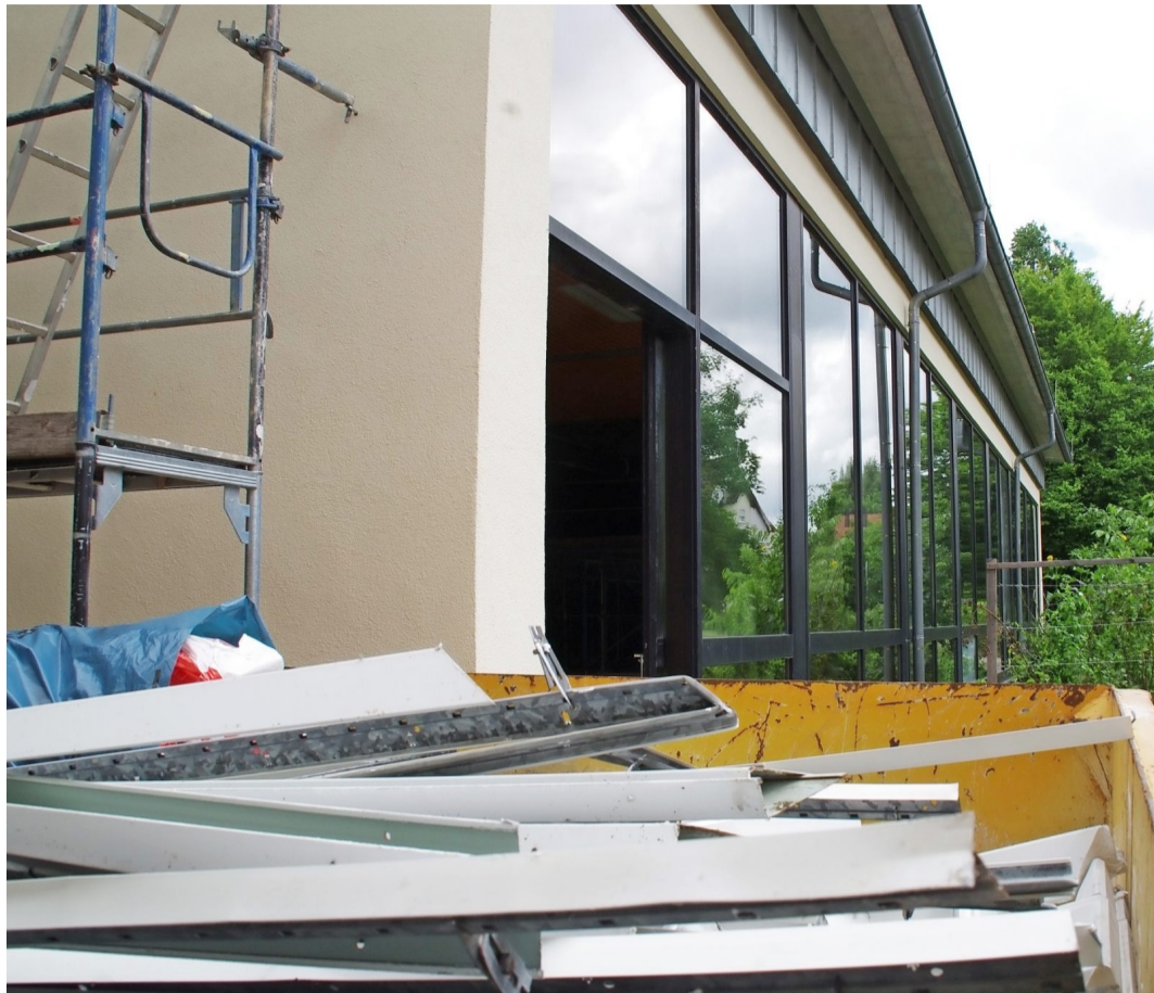
In der Mittelschule und dem Hallenbad sollen im Rahmen des Kommunalinvestitionsprogramms in diesem Jahr die Fenster erneuert werden.
