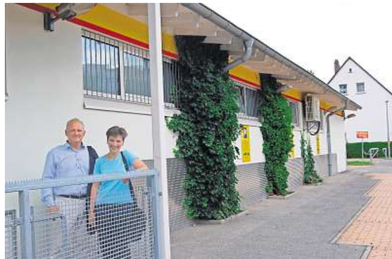
Bianca Fischer-Kilian und Loring Sittler vor dem hinteren Teil der ehemaligen Diska. Hier soll die Begegnungsstätte entstehen. Die Gitter vor den Fenstern kommen natürlich weg und die Fenster sollen bis zum Boden gehen, sagten beide am Montag. Foto: Regine Bellazrak
