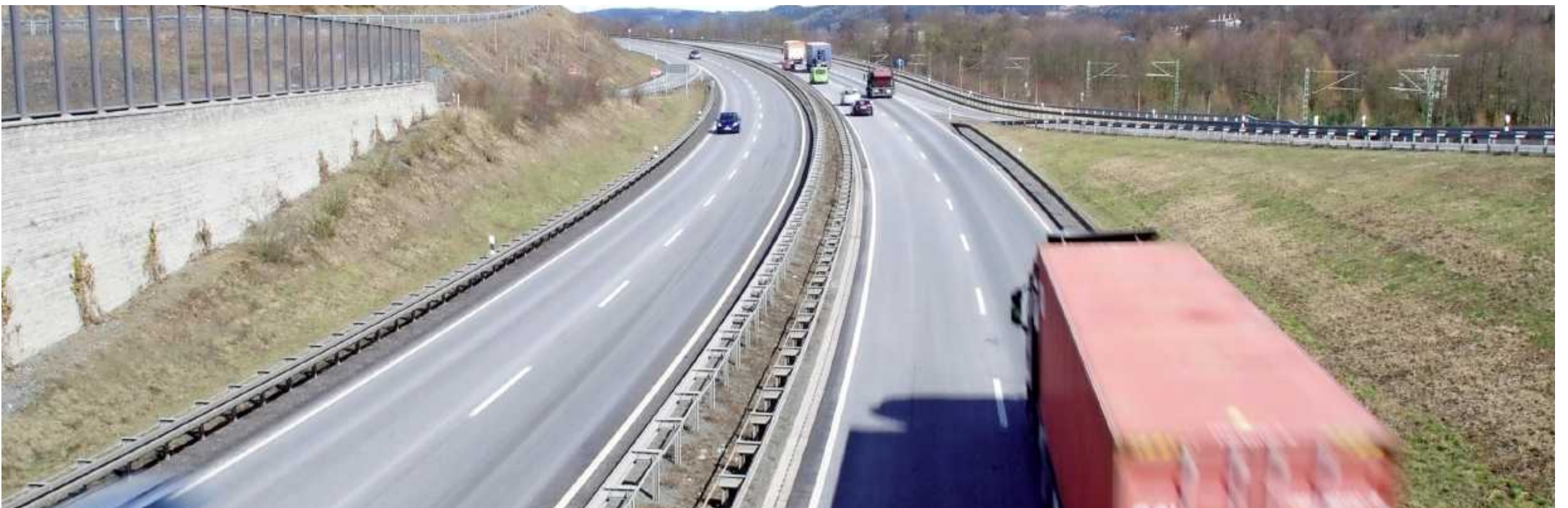
Auf der B 173 muss der Verkehr bei Neuses (in Fahrtrichtung Kronach) kurzzeitig eine Umleitung nutzen.
