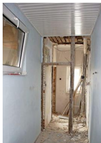
Hier werden einmal Toiletten sein.
