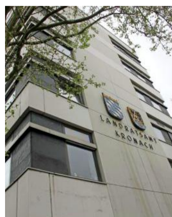
Das Landratsamt wird komplett saniert.
