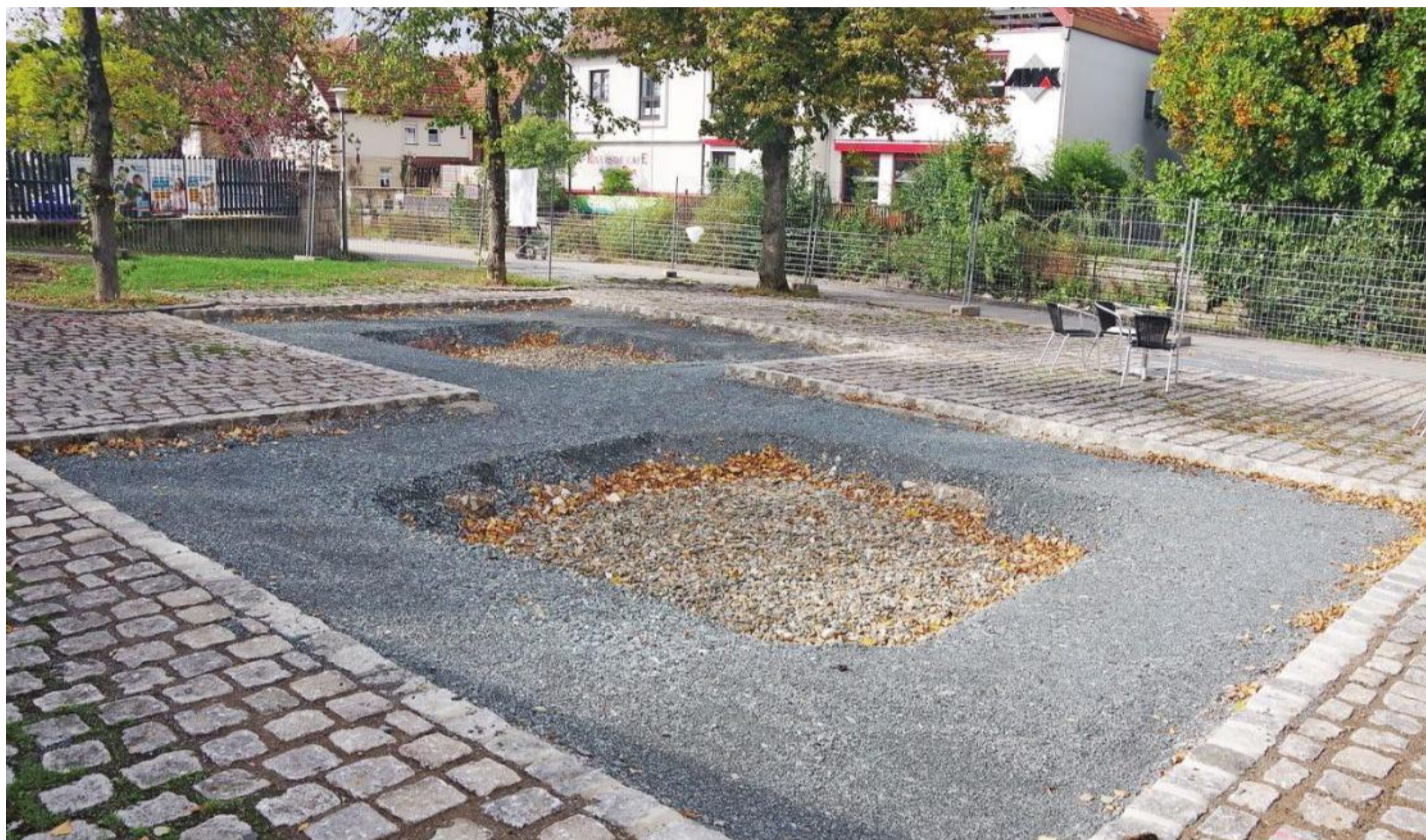
Hier entstehen zwei Trampoline mit Fallschutzmatten.
