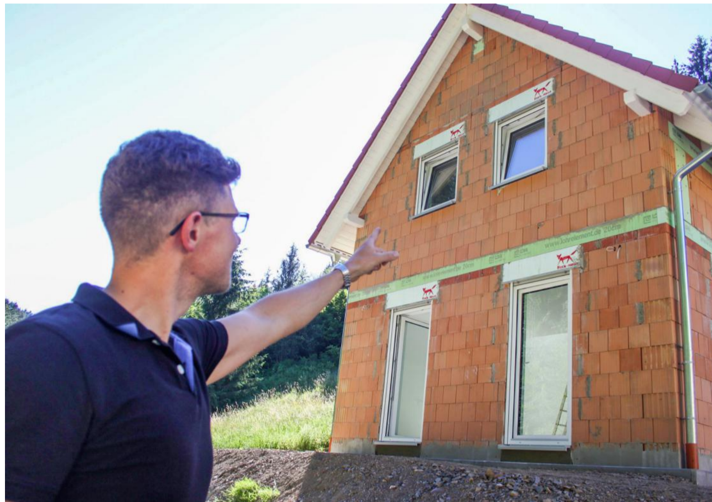
Arbeiten auf der Zielgeraden: Schritt für Schritt nimmt das Ferienhaus von Andreas Beetz Gestalt an.
