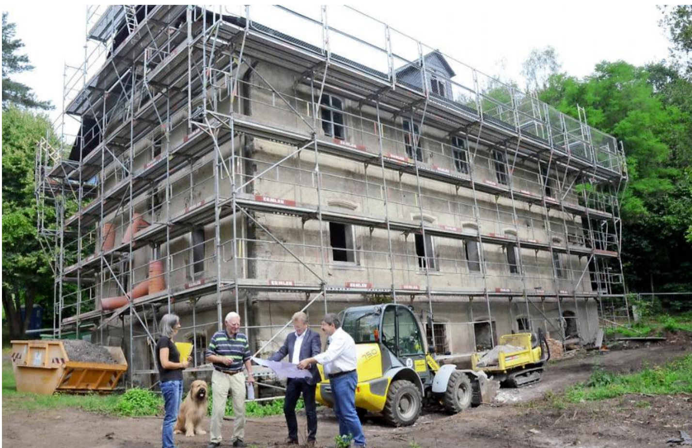
Bei einer Baustellenbesprechung vor der Rentei. Von links Kerstin Förttsch (Bauleitung Architekturbüro 3D Detsch), Hans Eichhorn (Baunternehmer), Bürgermeister Rainer Detsch und Planer Jörg Detsch. In diesem Bereich soll auch ein Biergarten entstehen. Fotos: K.-H. Hofmann
