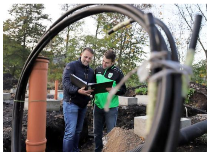
Zwei Jahre Planungsarbeit liegen hinter Daniel Weißerth (links) und René Schubart, nun kann es losgehen. Die ersten Schritte ihres Konzepts werden derzeit sogar schon umgesetzt. Foto: Marian Hamacher
