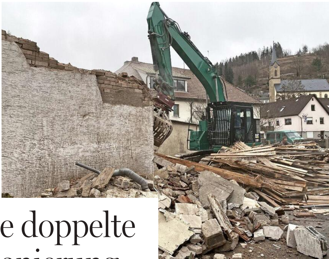
Aktuell wird am Wallenfeler Marktplatz das Gebäude Hausnummer 8 abgerissen, in dem früher eine Bäckerei untergebracht war. Hier soll ein Parkplatz für das Ärztehaus entstehen. Foto: Stadt Wallenfels
